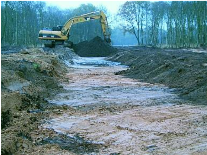
“Met graafmachines wordt een geul gemaakt voor de nieuwe loop van de Ruiten Aa”.
